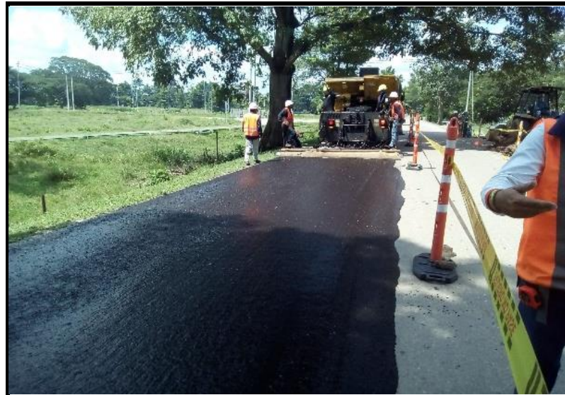
VIA YONDO PR2+900 AL PR 3+000 CALZADA DERECHA MICROAGLOMERADO
