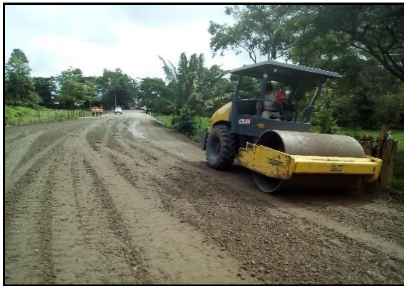
RELLENO EN SUB BASE TRAMO ESPECIAL PR 0+900 AL PR 1+200
