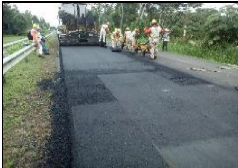
INSTALACION DE MDC-19 - MARGEN-IZQ PR6+815 AL PR7+060
