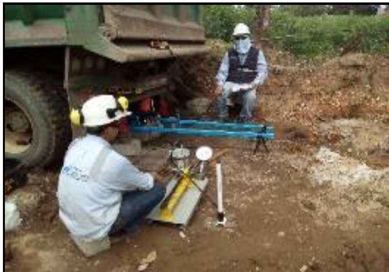
PRUEBA DE CARGA TRAMO ESPECIAL FUE REALIZADO FILA -19 PILOTE 6 - IZQ
