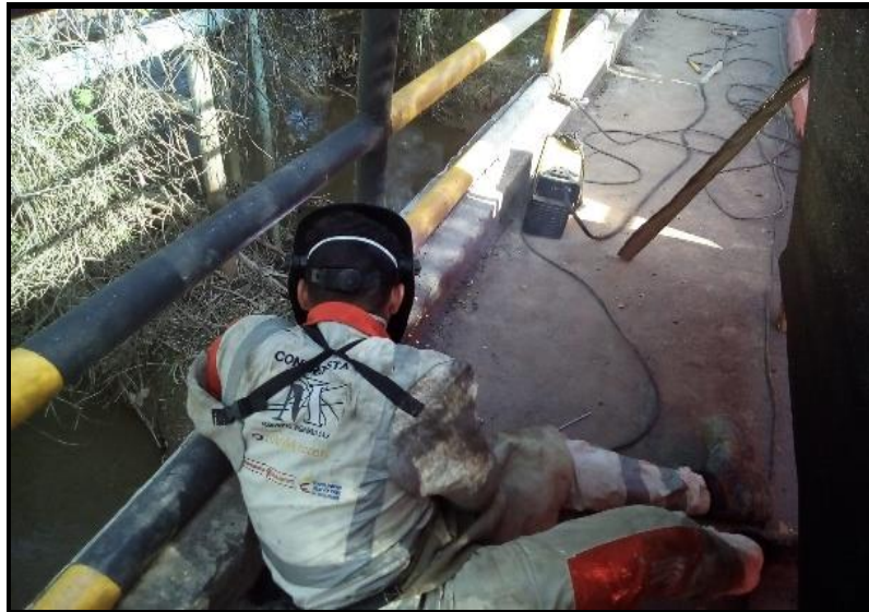
REPARACION BARANDA METALICA COSTADO DERECHO PUENTE 22 PR 5+050
