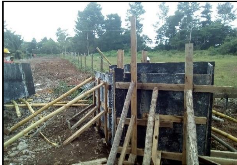
ENCOFRADA PARA FUNDIDA. TRAMO ESPECIAL REALCE CABEZOTE PR 1+191
