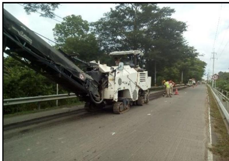
FRESADO PR 8+215 AL PR 8+600 DERECHO
