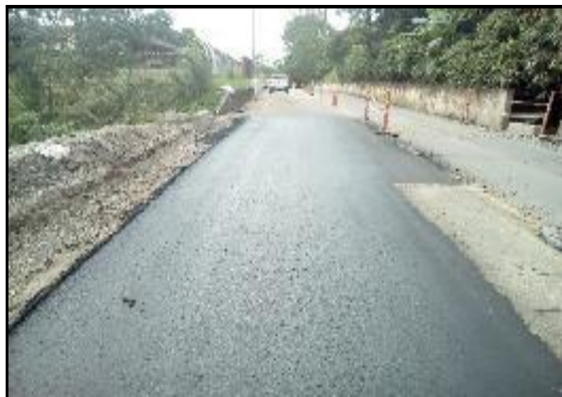
APLICACIÓN DE MDC PR37+902.5 AL PR 37+943-DER
