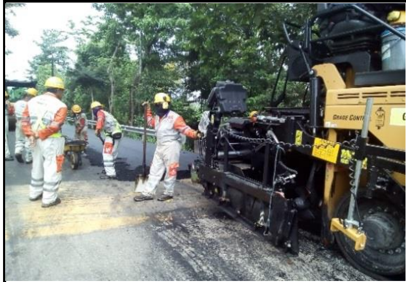
APLICACIÓN CARPETA ASFALTICA - EXTENDIDA PR 6+228 AL PR 6+518 CALZADA IZQUIERDA
