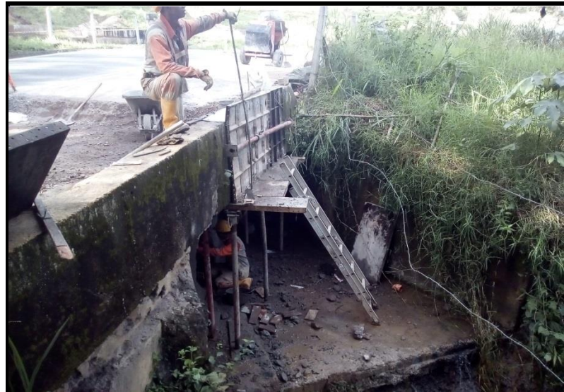
FUNDIDA DE CABEZOTE EN LA ALCANTARILLA PR 39+440-DER
