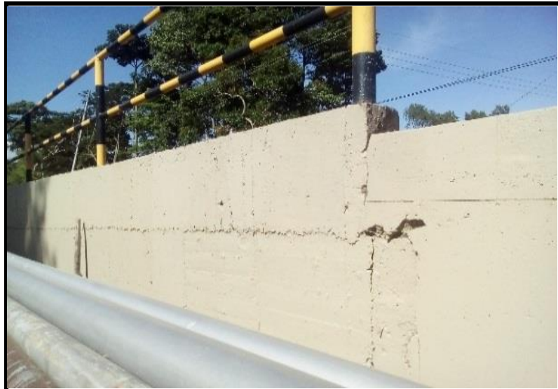
PR7+210 RESANE CON SIKA TOP 22 Y PINTURA
