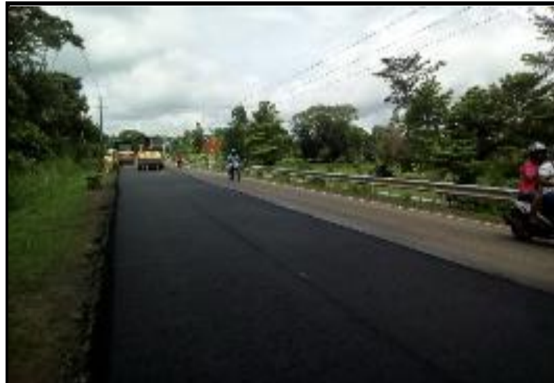
INSTALACION DE MDC-19 PR6+910 AL PR 7+300-DER
