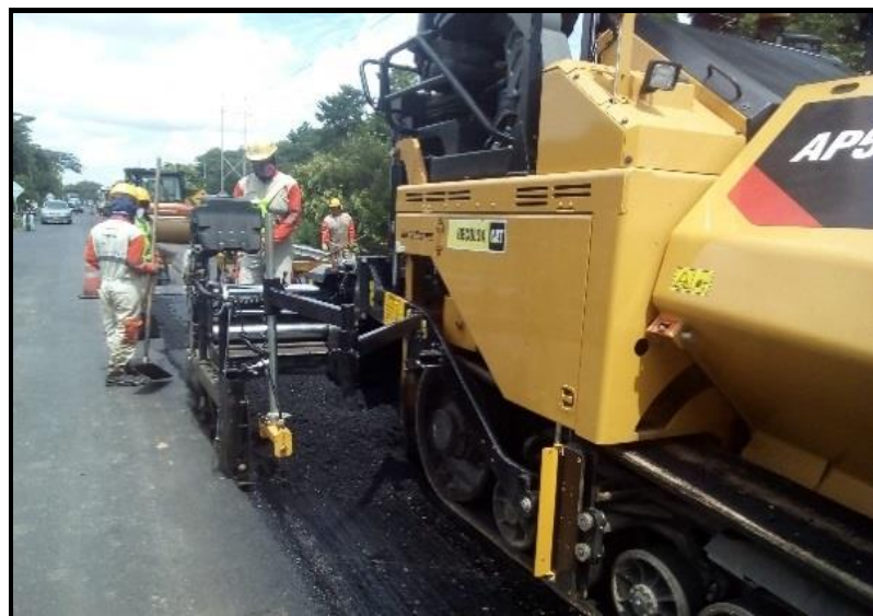
VIA YONDO PR 7+210 AL PR 7+465 CALZADA IZQUIERDA APLICACIÓN CARPETA ASFALTICA EXTENDIDA
