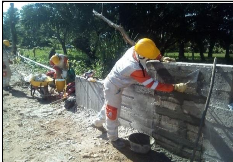
TRAMO ESPECIAL REFORZAMIENTO CABEZOTE DER TUB ALL PR 1+000
