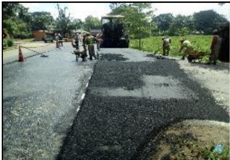
APLICACIÓN DE MDC-19 PR6+358 AL PR6+625-DER
