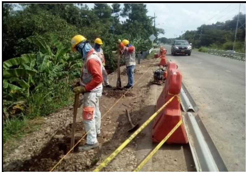
RELLENO E INSTALACION DE BARANDAS
