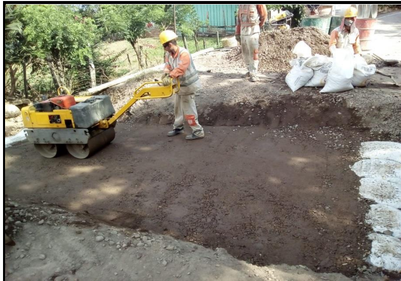
CONSTRUCCION DE LA ALCANTARILLA DEL PR34+525
