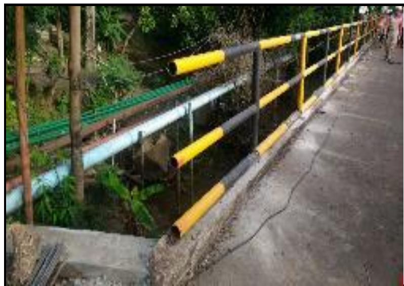
COLOCANDO PINES DE 1/2 PARA SOSTENER LA BARANDA MARGEN-DERECHA PUENTE PR5+040
