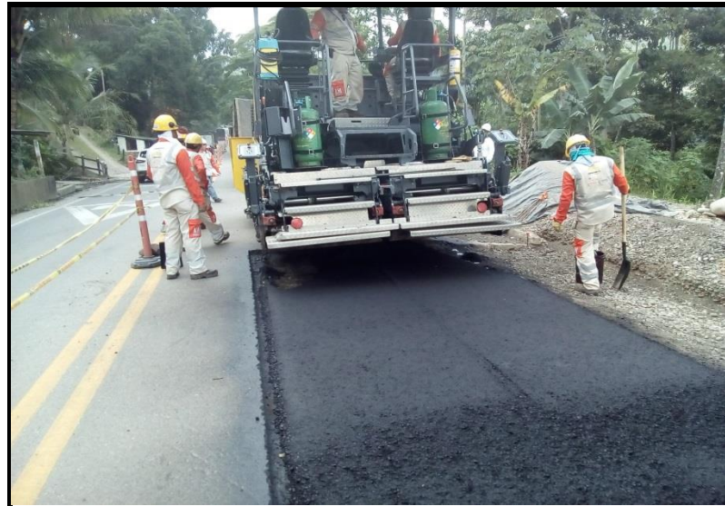
APLICACIÓN DE MDC PR37+902.5 AL PR 37+943-DER
