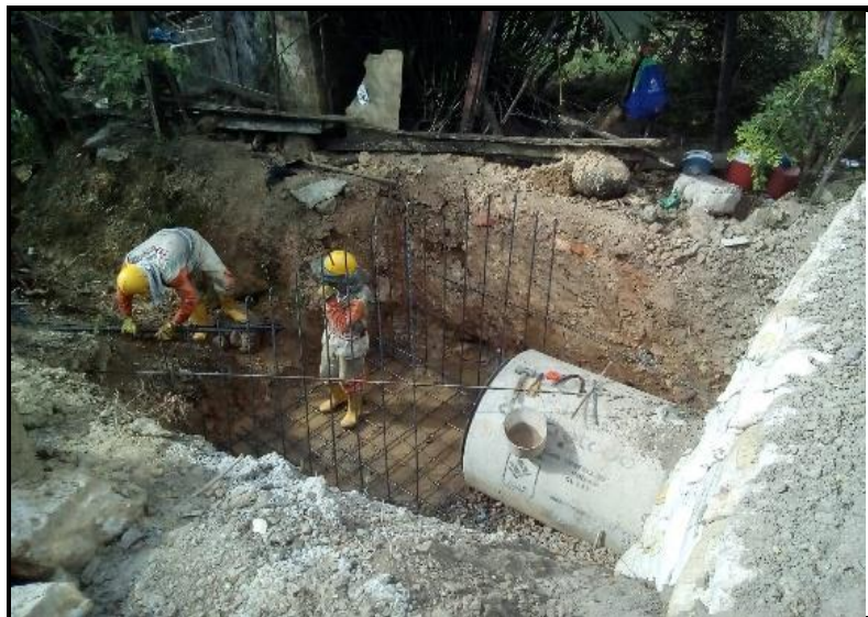
CONSTRUCCION CABEZALES TUBERIA AGUAS LLUVIAS PR 34+525
