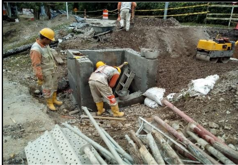
CONSTRUCCION DE ALCANTARILLA PR 36+560
