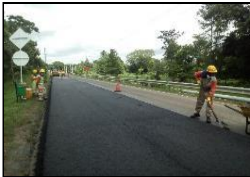
INSTALACION DE MDC-19 PR6+910 AL PR 7+300-DER
