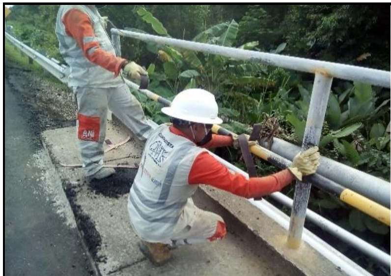
PUENTE PR 7+210 REPARACION BARANDAS METALICAS COSTADO IZQUIERDO
