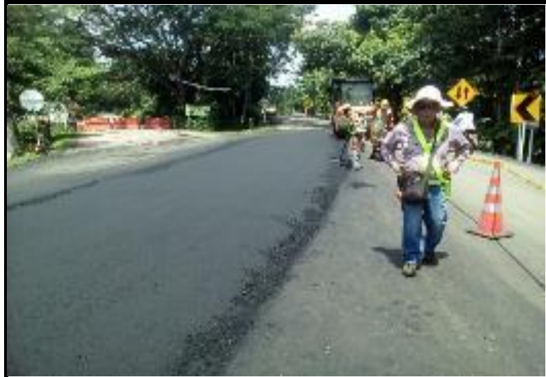
APLICACIÓN DE MDC-19 PR6+358 AL PR6+625-DER
