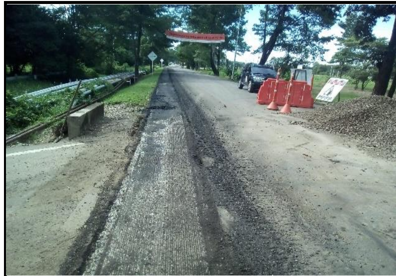
RETIRO DE LA SOBRE CARPETA QUE ESTABA EN OBSERVACION EN EL TRAMO ESPECIAL
