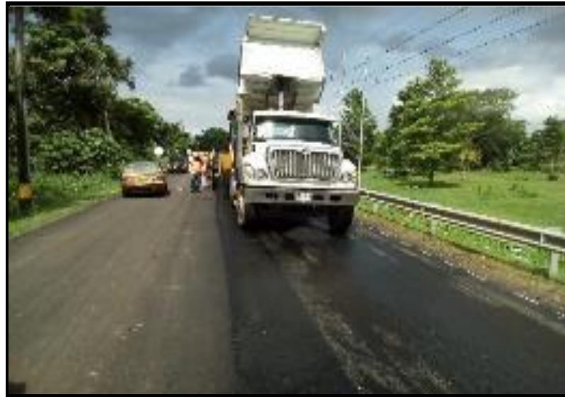
INSTALACION DE MDC-19 - MARGEN-IZQ PR6+815 AL PR7+060
