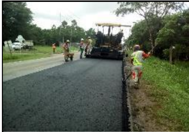
INSTALACION DE MDC-19 PR6+910 AL PR 7+300-DER
