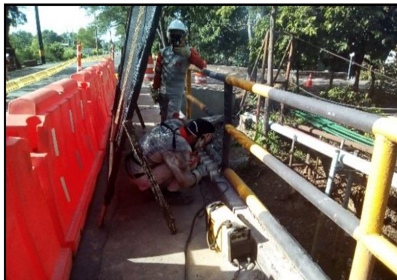
REPARACION BARANDA METALICA COSTADO DERECHO PUENTE 22 PR 5+050
