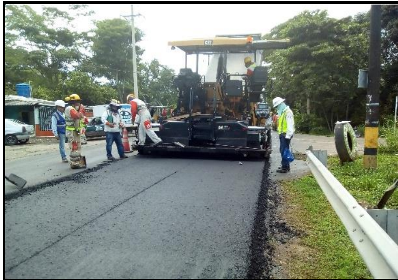
APLICACIÓN CARPETA ASFALTICA EXTENDIDA VIA YONDO PR 7+848 AL PR 8+162 CALZADA DERECHA
