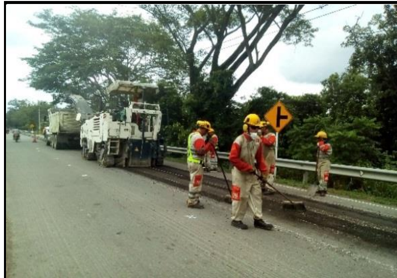
FRESADO PR 8+215 AL PR 8+600 DERECHO
