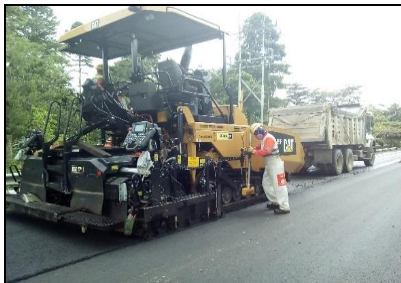
VIA YONDO PR 7+723 AL PR 8+010 CALZADA IZQUIERDA APLICACIÓN CARPETA ASFALTICA EXTENDIDA
