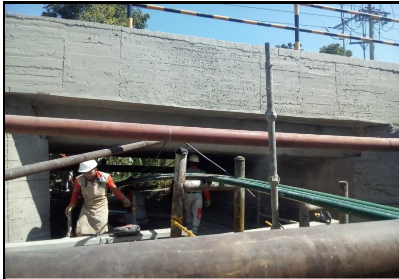
REFUERZO ESTRUCTURAL DEL PONTON PR7+210
