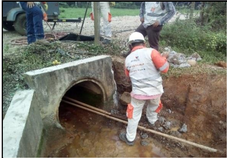
TRAMO ESPECIAL REALCE CABEZOTE PR 1+191
