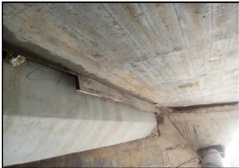
PR7+210 RESANE CON SIKA TOP 22 Y PINTURA
