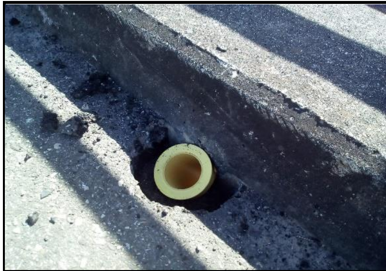
CAMBIO DE LLORADEROS TUBERIA EN PVC 4" PUENTE GUILLERMO GAVIRIA
