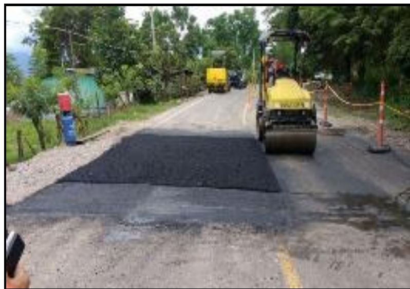
APLICACIÓN MDC-19 EN PR34+525-IZQ-DER
