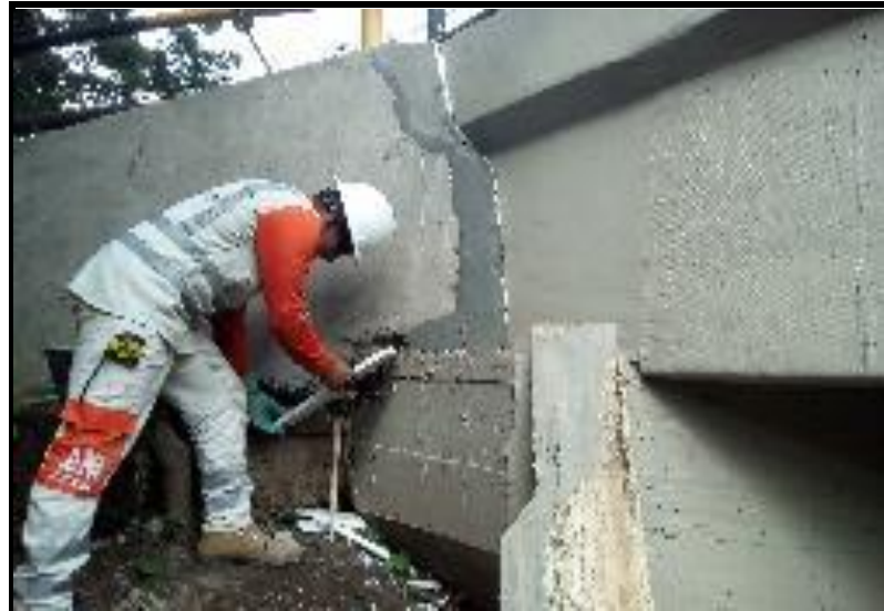
RESANE DE ALETAS COSTADO NORTE MARGEN-DERECHA
